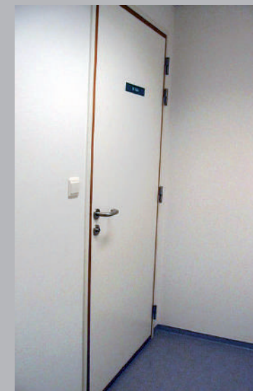
✗ MWanden, vloeren en deuren vertonen onvoldoende kleurcontrasten
