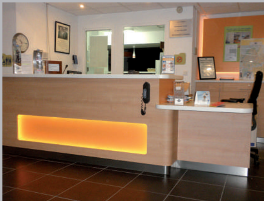
✗ Verlaagd werkblad is niet diep genoeg
