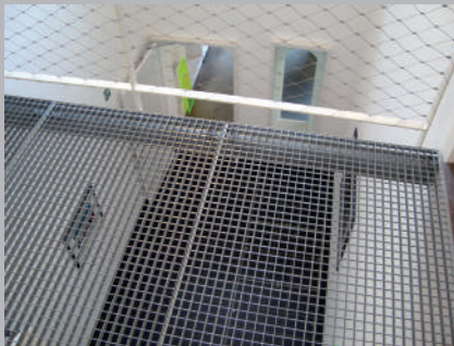
✗ Opengewerkte vloerbedekking
