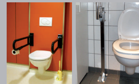
✗ Bevestigingsschoen in de transferzone
