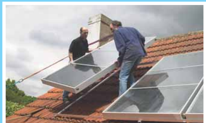
Installation de panneaux solaires construits en équipe
